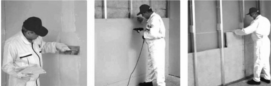
شکل ۴-۲- تصویری از مراحل عایق کاری دیوار
